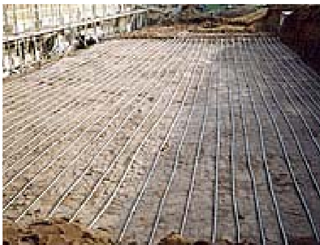
Bild 1.1 Verlegung eines Erdwärmekollektors aus Kunststofffrohrschnangen (Quelle: www.gesell-camburg.de/referenzen.html )
