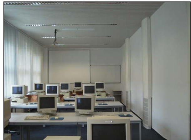
Bild 10.16 Rechnerpool während der Montage und im fertiggestellten Zustand mit Quellsystem und einem Abluftgitter in der Deckenmitte
