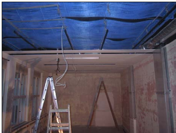
Bild 10.16 Rechnerpool während der Montage und im fertiggestellten Zustand mit Quellsystem und einem Abluftgitter in der Deckenmitte
